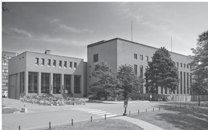
オープンした新棟全景（右手建物）
